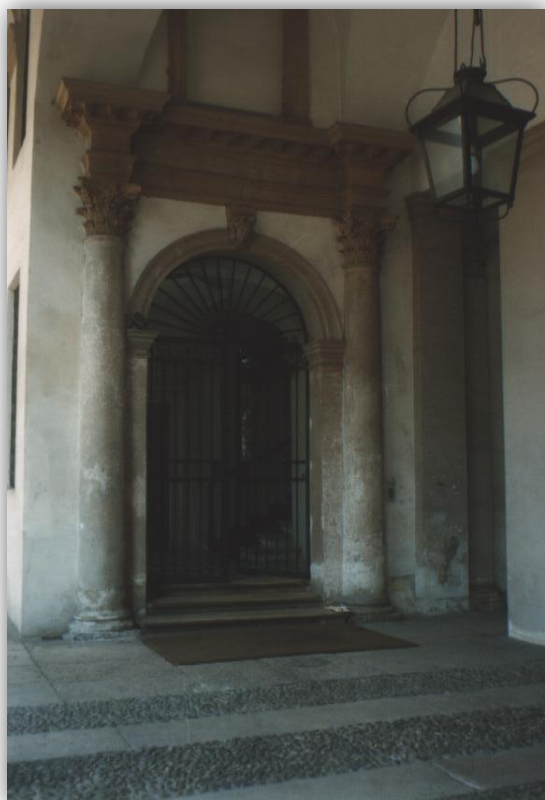
FIGURA 57 - L'ANDRONE PRIMA DEL RESTAURO
