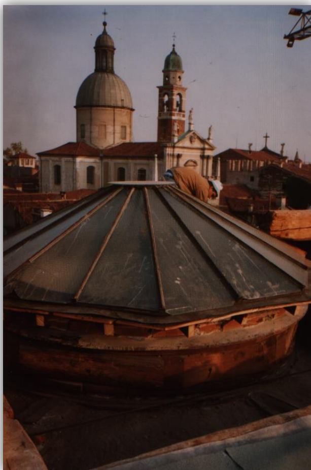
FIGURA 64 - LANTERNA CENTRALE DELLA CUPOLA DELLA SCALA ROTONDA PRIMA DELL'INTERVENTO
