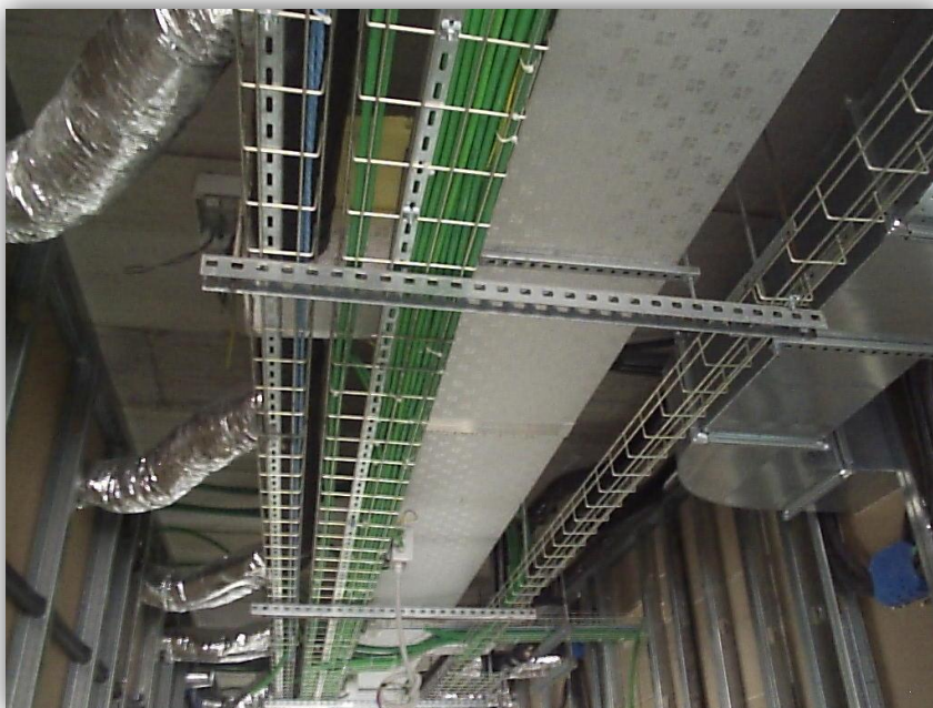
FIGURA 140 - ELEKTRA SRL – NUOVA SEDE DELLA CISL A VICENZA PARTICOLARE DEL CABLAGGIO DI UN CORRIDOIO – FEBBRAIO 2010
