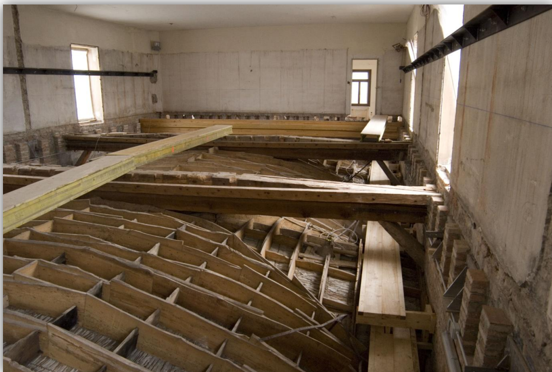
FIGURA 115 - ESTRADOSSO DELLE VOLTE DELLA CHIESA DEL SEMINARIO SETTEMBRE 2007
