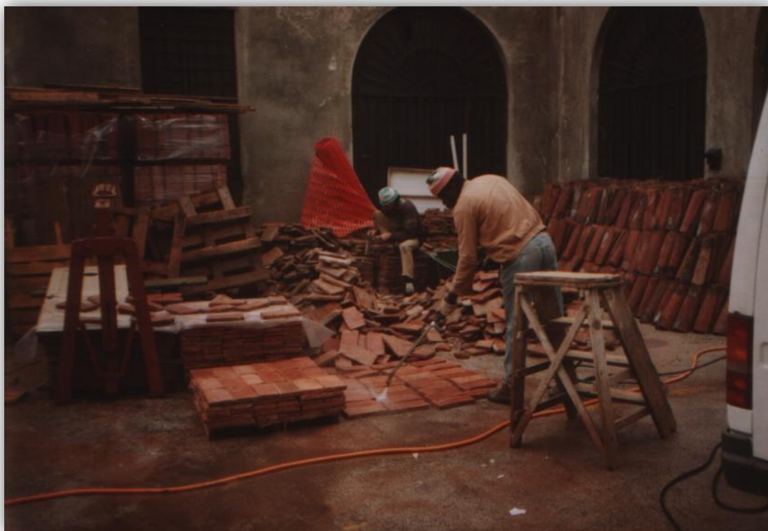
FIGURA 67 - RECUPERO E LAVAGGIO DELLE TAVELLINE
