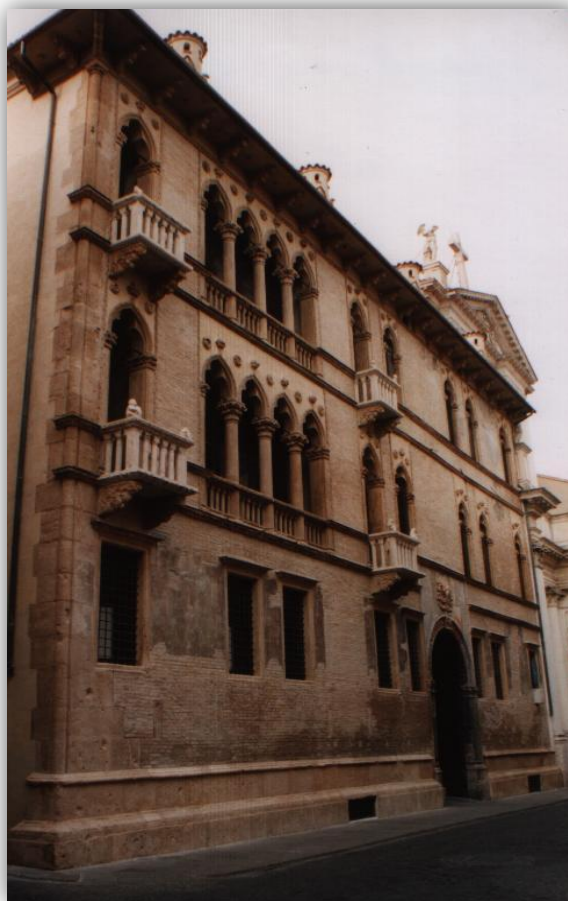
FIGURA 71 - LA CA’ D’ORO, LA FACCIATA DOPO IL RESTAURO
