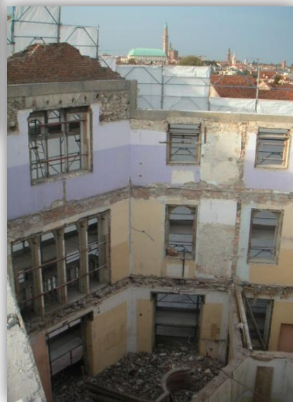
FIGURA 97 - DEMOLIZIONE SOLAI INTERPIANO E MURATURE DIVISORIE INTERNE
