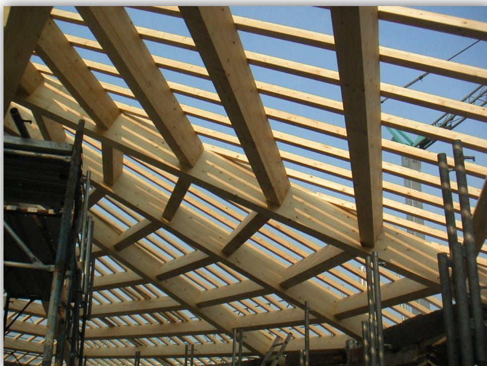
FIGURA 103 - POSA DELL'ORDITURA SECONDARIA DELLA STRUTTURA DI COPERTURA
