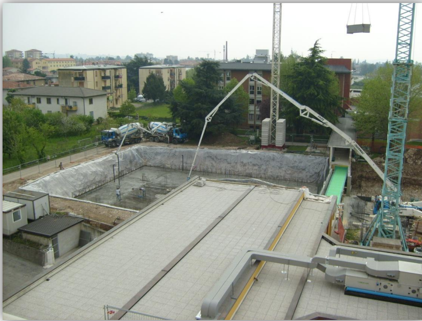
FIGURA 82 - IL CANTIERE OIC DI THIENE GETTO PLATEA DI VILLA 2 APRILE 2010
