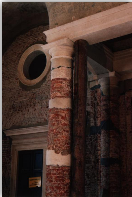
FIGURA 65 - RESTAURO DELLA COLONNA PORTANTE DELL'ANDRONE
