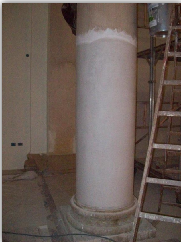
FIGURA 126 - STESA DELLA TINTEGGIATURA AD ALTA TRASPIRABILITÀ SIKKEN
