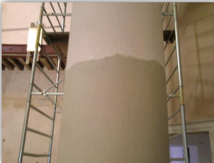
FIGURA 125 - FASE DI INTONACATURA DELLE COLONNA PRECEDENTEMENTE RISANATE DALL'UMIDITÀ
