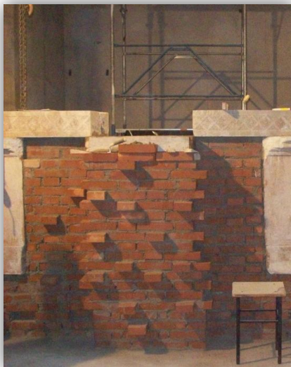
FIGURA 130 - REALIZZO DI UN BASAMENTO IN MATTONI PIENI
