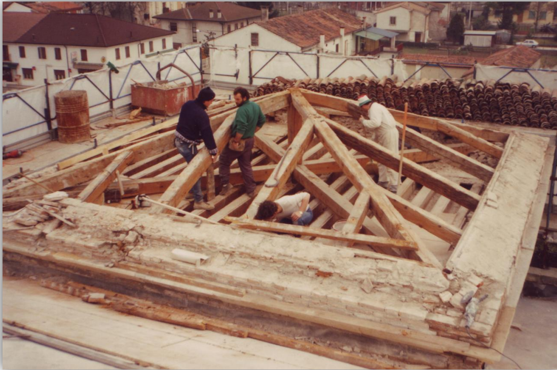
FIGURA 37 - RICOSTRUZIONE ORDITURA PRINCIPALE DELLA TORRETTA
