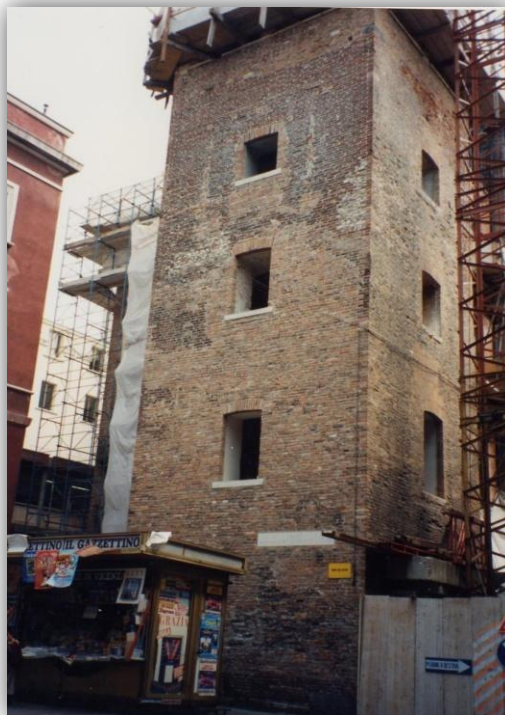
FIGURA 75 - TORRE DEI LOSCHI DURANTE I LAVORI DI RESTAURO DELLA COLONNA PORTANTE DELL'ANDRONE
