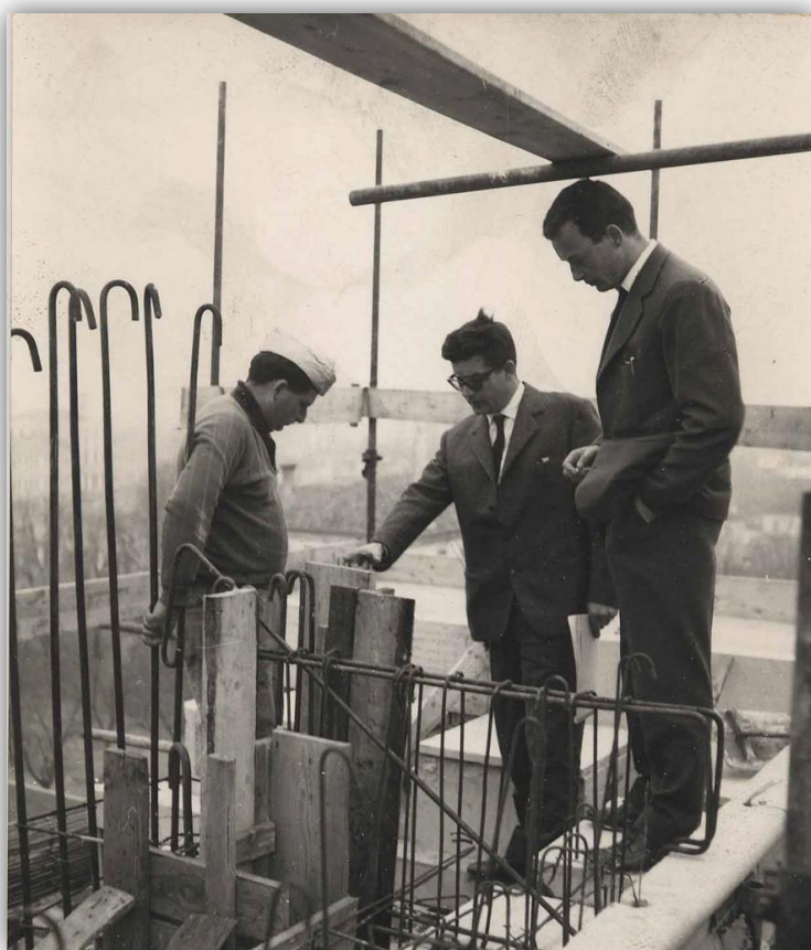
FIGURA 33 - IL DUOMO DI NOVENTA. L'ING. VESCOVI (A DESTRA) CONTROLLA LE ARMATURE CON L'ING. SERBLIN E RINO VISENTIN (1969)
