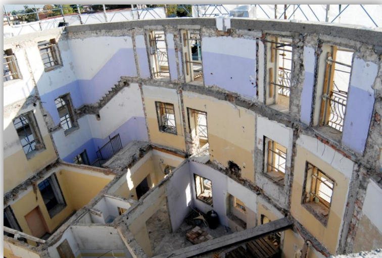
FIGURA 95 – RIMOZIONE ORDITURA LIGNEA PRINCIPALE DEL SOLAIO DI COPERTURA
