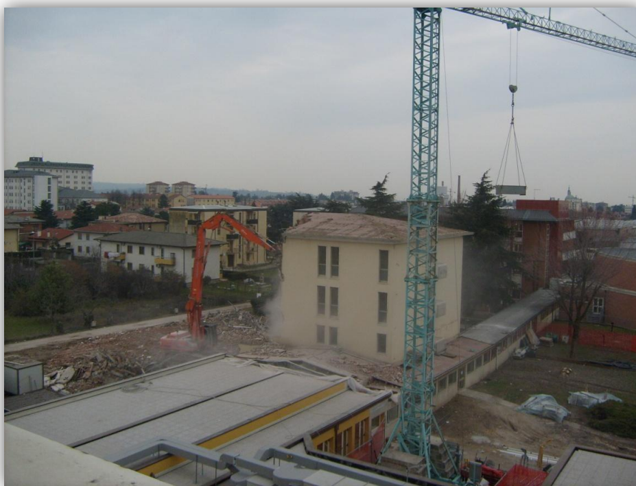
FIGURA 81 - DEMOLIZIONE DI VILLA 2 NEL CANTIERE OIC DI THIENE FEBBRAIO 2010
