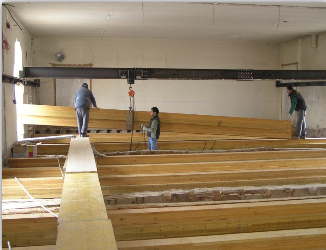
FIGURA 113 - MOVIMENTAZIONE DELLE NUOVE TRAVI IN LARICE LAMELLARE
