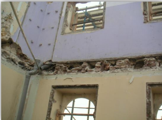
FIGURA 98 - TECNICA DEL CUCI SCUCI DOVE, UN TEMPO, ERANO INSERITE LE TRAVI IN LEGNO DEL SOLAIO
