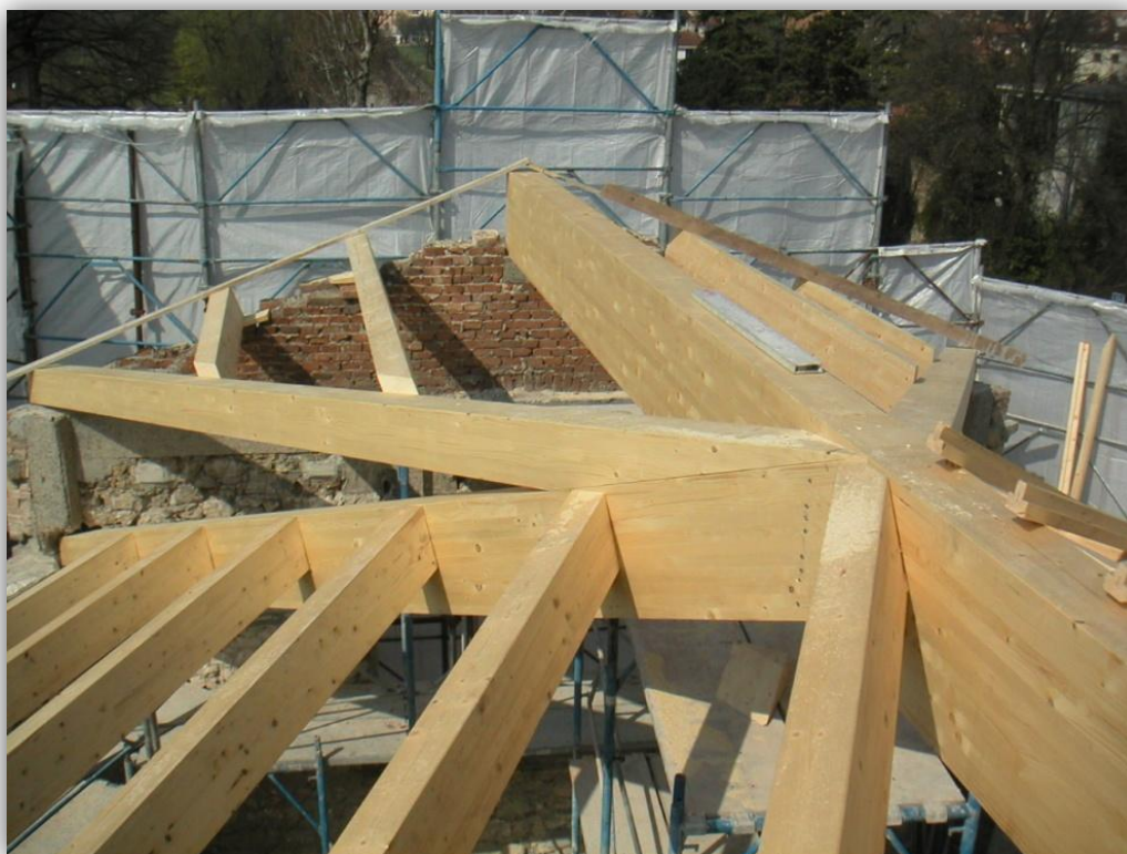
FIGURA 102 - POSA DELL'ORDITURA PRINCIPALE DELLA STRUTTURA DI COPERTURA E DELLA TRAVE DI COLMO
