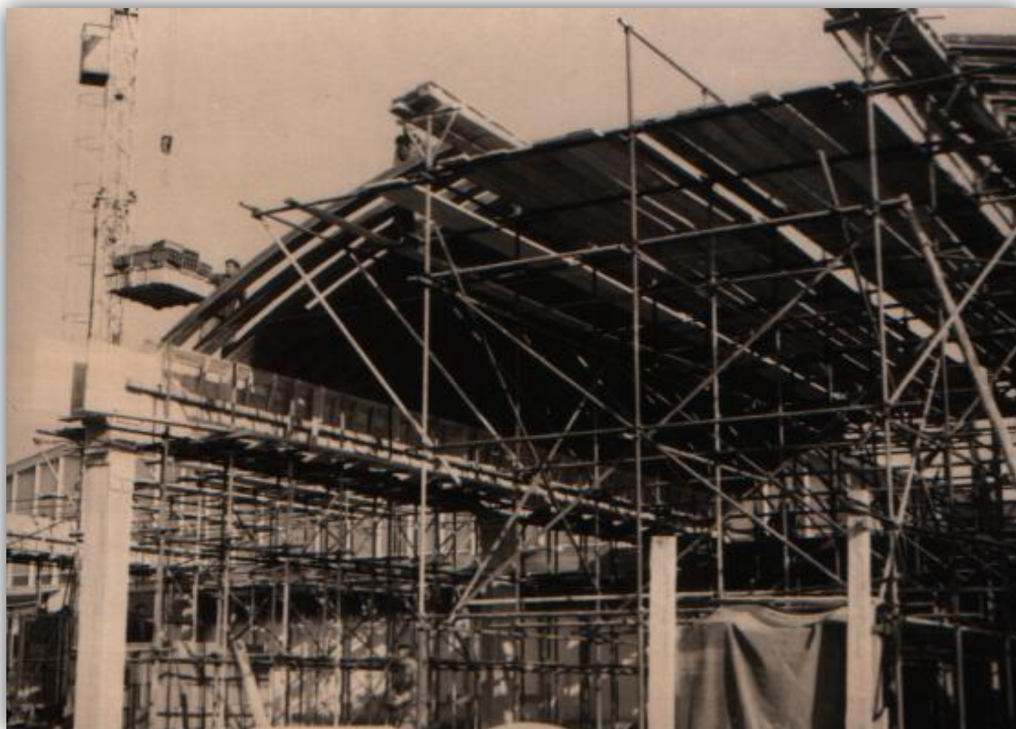
FIGURA 30 - IMPALCATURE PER LA COSTRUZIONE DELLO STABILIMENTO DELLE GRAFICHE ZORDAN (1963). DA NOTARE LA DIFFERENZA CON QUELLE ODIERNE!
