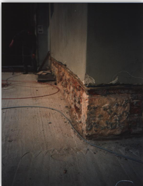
FIGURA 59 - PARTICOLARE DEL TAGLIO DELLA MURATURA NELL'ATRIO PER L'INSERIMENTO DI UN FOGLIO IN VETRORESINA PER PREVENIRE LA RISALITA DELL'UMIDITÀ
