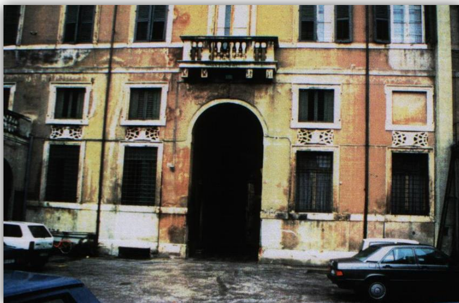
FIGURA 63 - IL CORTILE INTERNO PRIMA DEL RESTAURO
