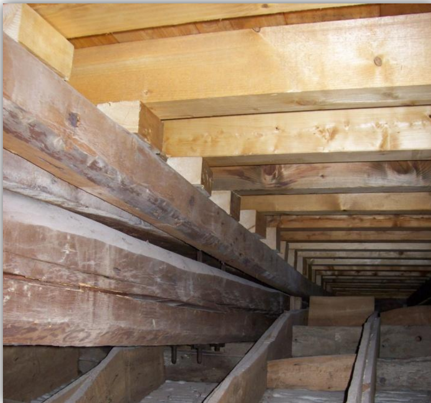
FIGURA 107 - POSA IN OPERA DI NUOVE TRAVI SECONDARIE IN ABETE TRATTATE CON ANTITARLO TIMPEST
