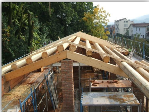
FIGURA 92 - POSA STRUTTURA LIGNEA DI COPERTURA
