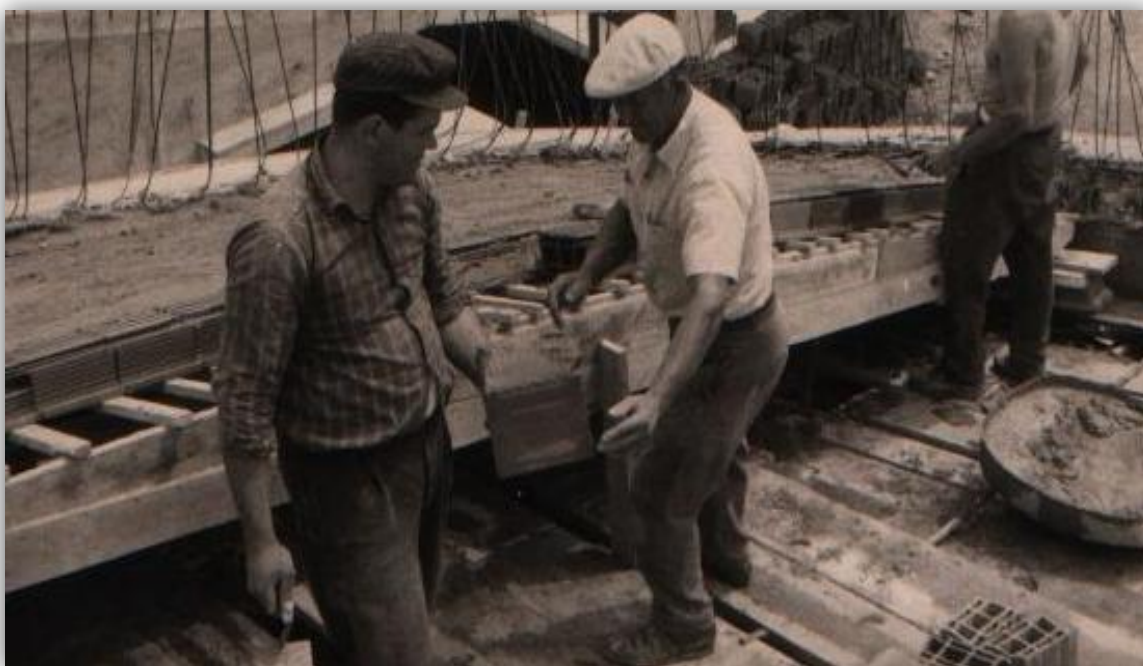
FIGURA 31 - OPERAI AL LAVORO PER LA COSTRUZIONE DELLO STABILIMENTO DELLE GRAFICHE ZORDAN (1963)
