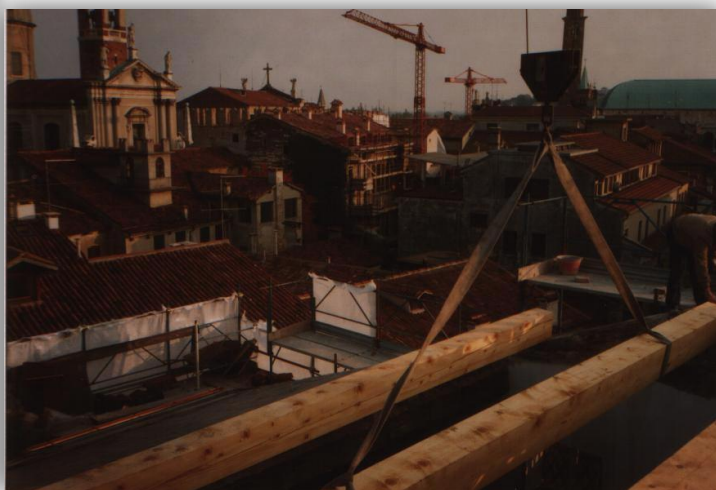
FIGURA 66 - SOSTITUZIONE DELLE TRAVI DANNEGGIATE
