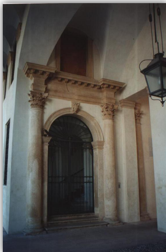
FIGURA 58 - L'ANDRONE DOPO IL RESTAURO
