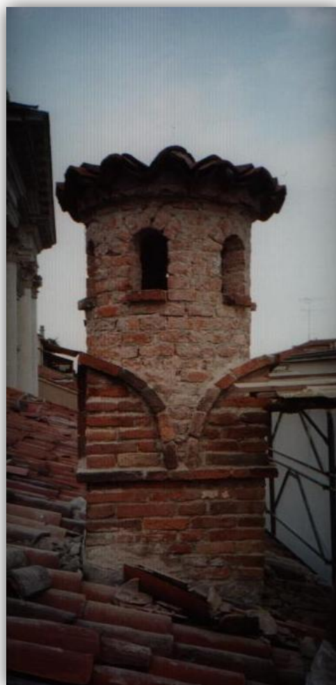
FIGURA 72 - PARTICOLARE DEL RESTAURO DEL TETTO
