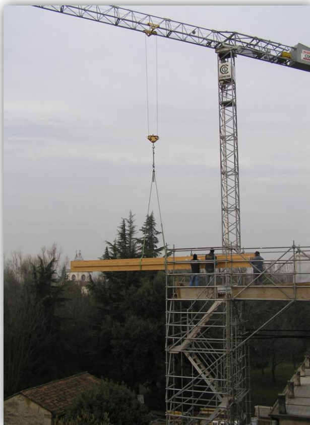
FIGURA 112 - MOVIMENTAZIONE DELLE NUOVE TRAVI IN LARICE LAMELLARE
