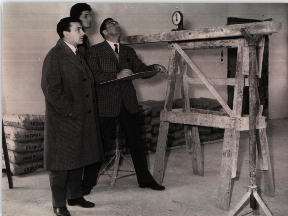
FIGURA 22 - PROVE DI CARICO COL FLESSOMETRO: ALCUNI TECNICI TESTANO LA TENUTA DEI SOLAI DEL GENIO CIVILE
