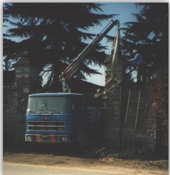
FIGURA 53 - VILLA PIGATTI POSA DEL PILASTRO DEL CANCELLO
