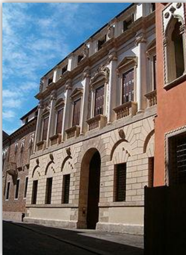
FIGURA 61 - PALAZZO DA PORTO FESTA DOPO IL RESTAURO
