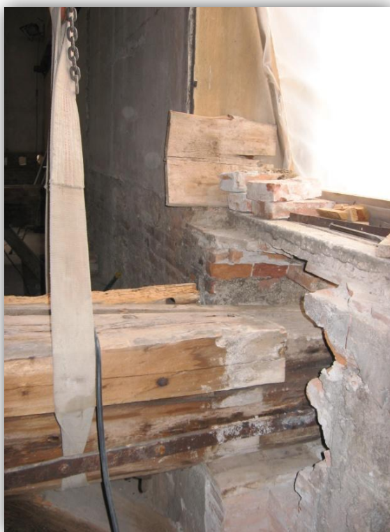
FIGURA 105 - SOLLEVAMENTO PER IL RISANAMENTO IN LOCO DI DUE TRAVI COMPOSTE
