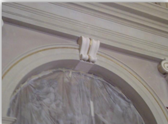
FIGURA 134 - RESTAURO DELLE CHIAVI DI VOLTA
