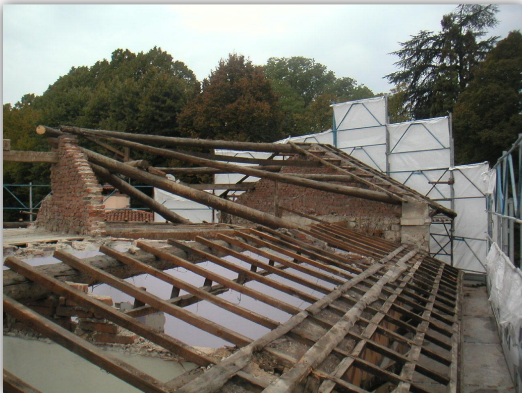
FIGURA 95 – RIMOZIONE ORDITURA LIGNEA PRINCIPALE DEL SOLAIO DI COPERTURA
