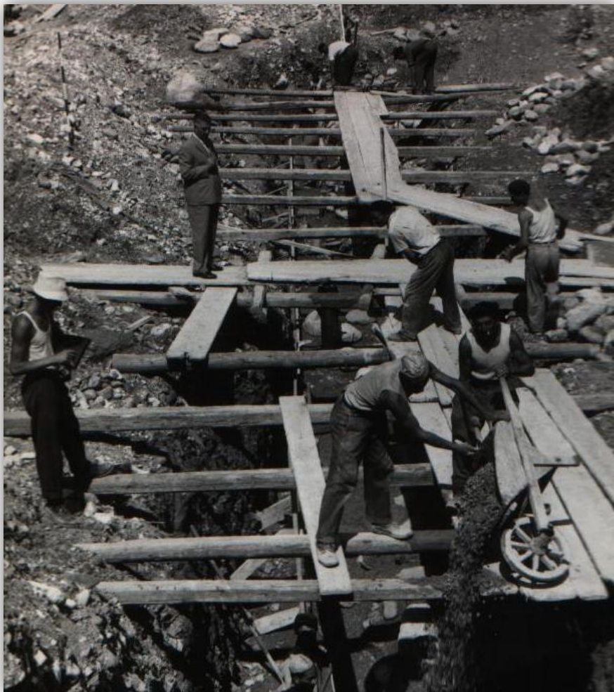
FIGURA 27 - COLATA DI CEMENTO DALLA CARRIOLA... NOTARE ANTONIO VESCOVI IN CANTIERE IN GIACCA E CRAVATTA
