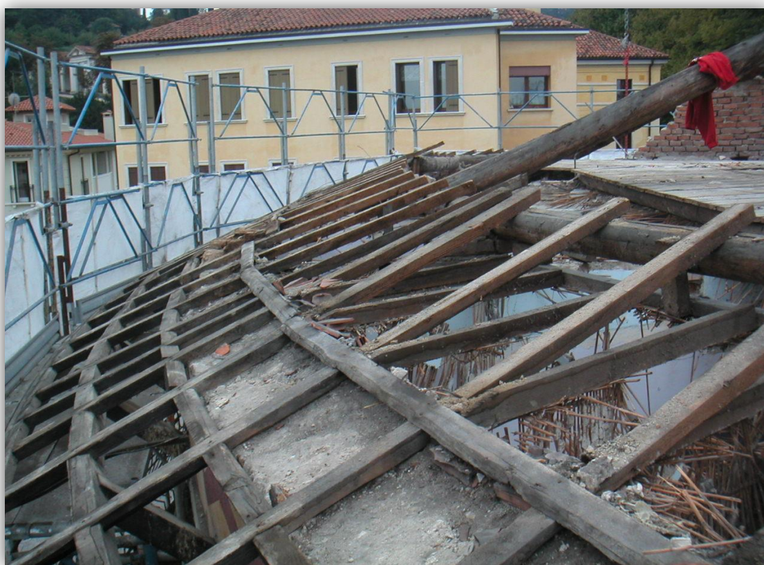
FIGURA 94 - DEMOLIZIONE SOLAIO DI COPERTURA
