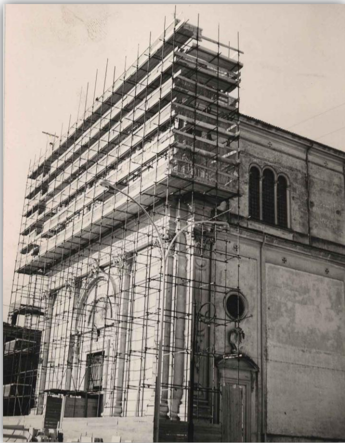
FIGURA 32 - IL DUOMO DI NOVENTA DURANTE IL RESTAURO
