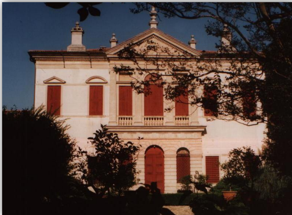
FIGURA 50 - VILLA PIGATTI, LA FACCIATA, DOPO IL RESTAURO
