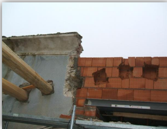
FIGURA 92 - POSA STRUTTURA LIGNEA DI COPERTURA
