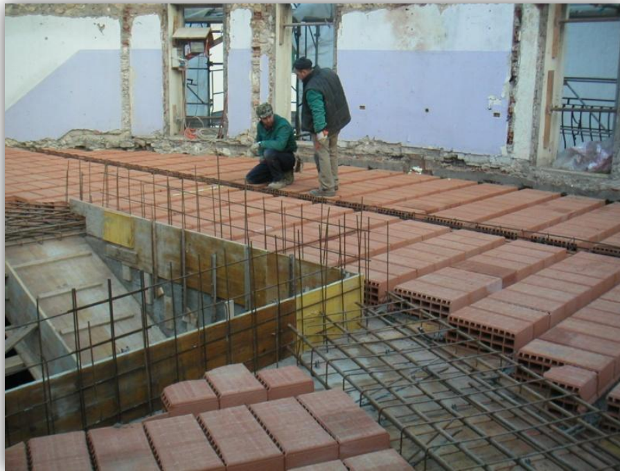
FIGURA 100 - POSA DEL SOLAIO LATERO-CEMENTO AL PIANO SECONDO
