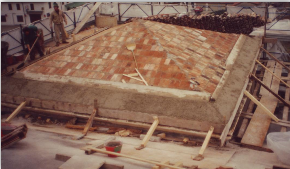
FIGURA 39 - MANTO DELLA TORRETTA IN TAVELLINE DI RECUPERO
