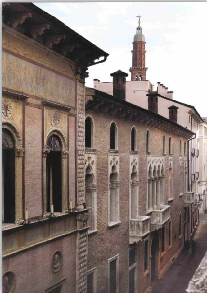
FIGURA 68 - PALAZZO THIENE, FACCIA DA DOPO IL RESTAURO
