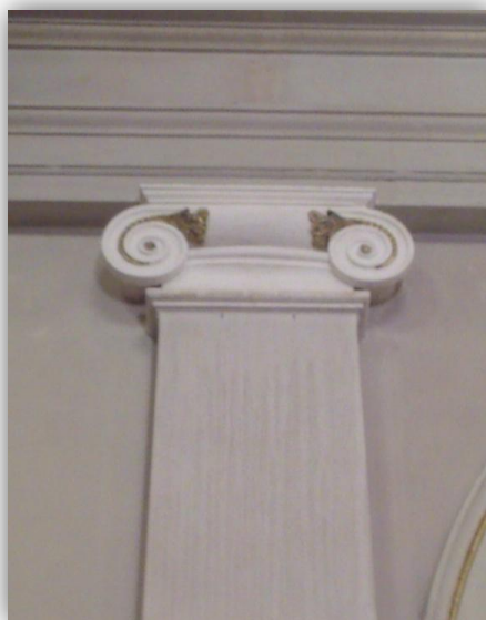
FIGURA 135 - RESTAURO DEI CAPITELLI
