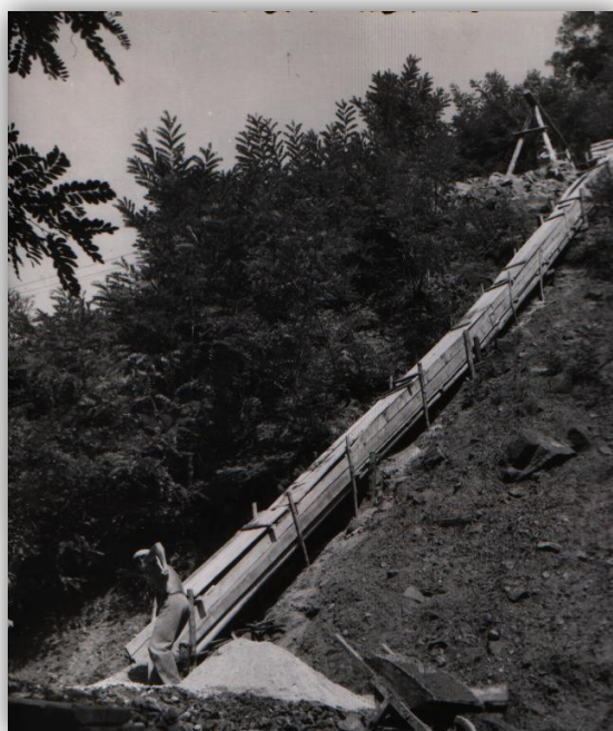
FIGURA 29 - SCARICO DI SABBIA DALLA STRADA SOPRASTANTE PER COSTRUIRE UN ARGINE
