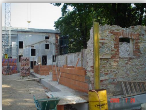
FIGURA 90 - MURATURA ESISTENTE E NUOVA IN ELEVAZIONE: STADI AVANZAMENTO LAVORI
