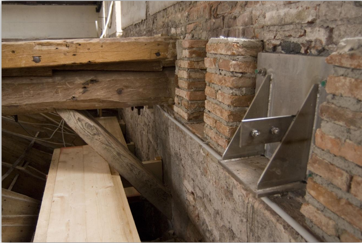
FIGURA 114 - SELLA DI APPOGGIO IN ACCIAIO INOX DELLE NUOVI TRAVI IN LEGNO LAMELLARE DI LARICE SULLO SFONDO ANTICA TRAVE COMPOSTA DOPO IL RESTAURO E LA RICOLLOCAZIONE IN OPERA
