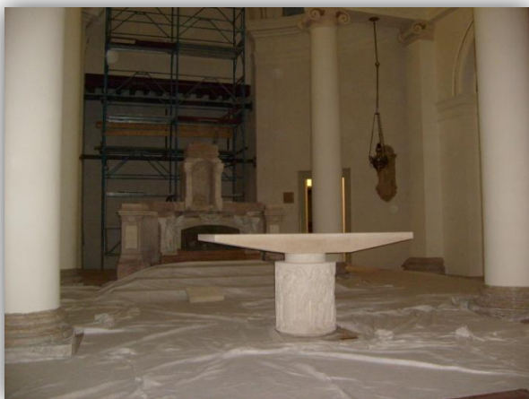
FIGURA 132 - VISTA DELLA POSIZIONE DEI DUE ALTARI: ALTARE DELLA MENSA E ALTARE DELLA RIPOSIZIONE ANCORA IN FASE DI LAVORAZIONE
