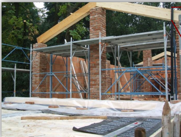
FIGURA 91 - SELLA D'APPOGGIO DELLA STRUTTURA LIGNEA DI COPERTURA
