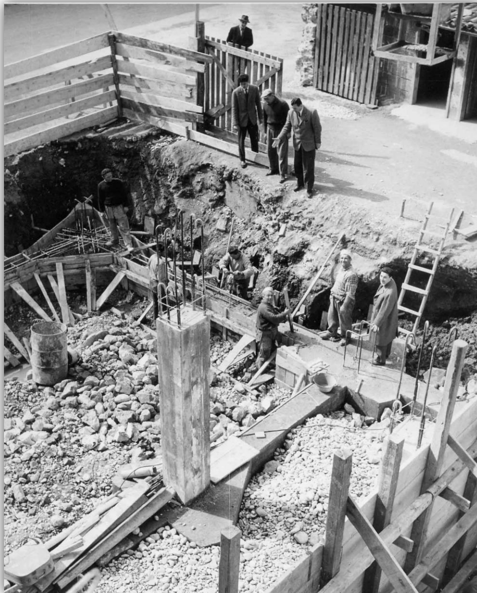
FIGURA 20 - LE FONDAMENTA DEL PALAZZO DEL GENIO CIVILE
