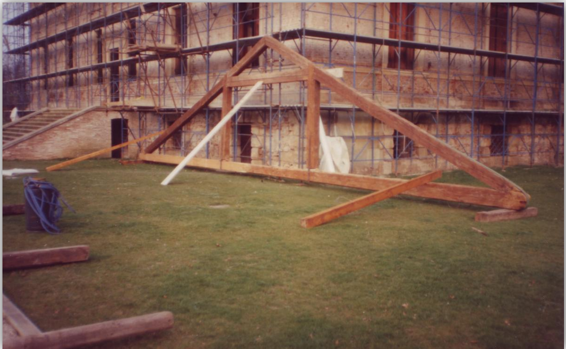
FIGURA 42 - RICOMPOSIZIONE DELLA CAPRIATA
