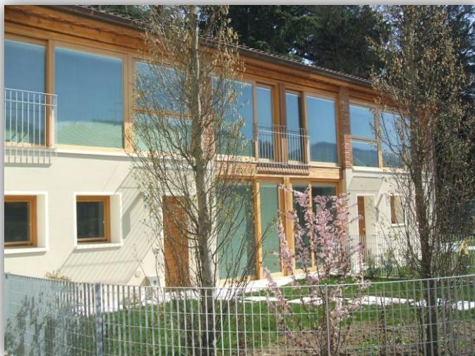
FIGURA 88 - STATO DELL'OPERA A FINE LAVORI
