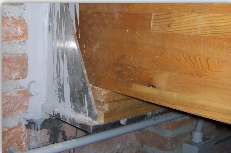
FIGURA 108 - SELLE METALLICHE PER LA POSA DELLE TRAVI LAMELLARI PRINCIPALI E INTERPOSIZIONE DI TAVOLETTE IN LARICE
