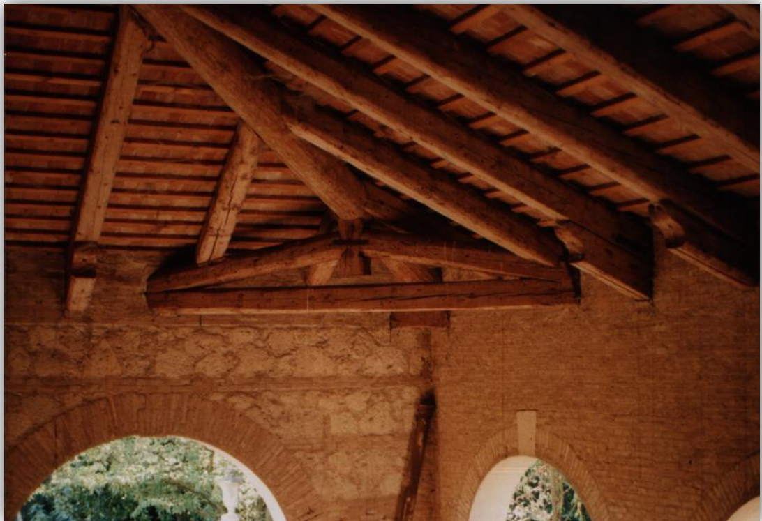
FIGURA 52 - VILLA PIGATTI, IL RESTAURO DELLE TRAVATURE
