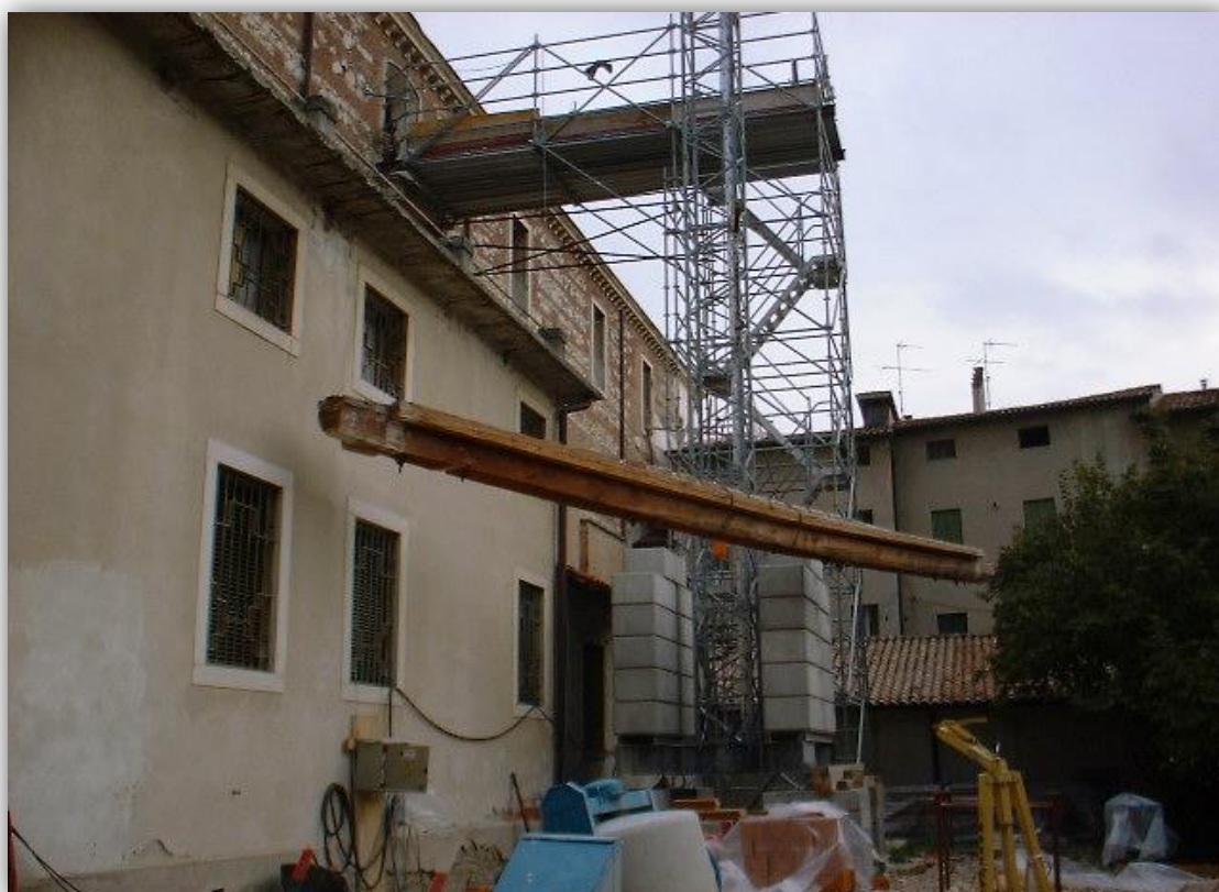
FIGURA 106 - ABBASSAMENTO NEL CORTILE ESTERNO DELLA TERZA TRAVE COMPOSTA
