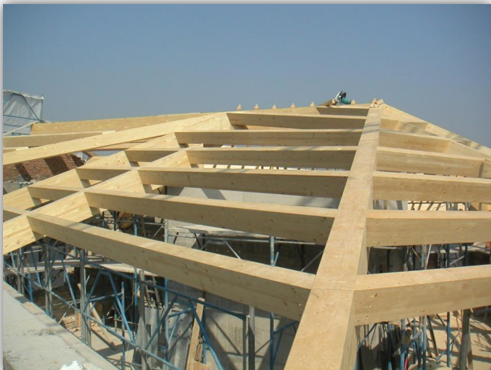
FIGURA 101 - POSA DELL'ORDITURA DELLE TRAVI MAESTRE IN LEGNO LAMELLARE
